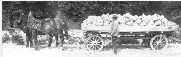
1876: Der abgebaute Kalk wurde mit Pferdefuhrwerken zum Bahnhof gefahren und dort in Bahnwaggons verladen.
